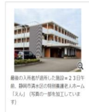
最後の入所者が退去した施設 = 23日午前、静岡市清水区の特別養護老人ホーム「えん」（写真の一部を加工しています）
